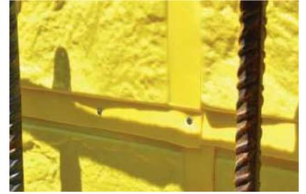
**3.3.- Fijación mediante precinto a doble cara, según modelos.** Se aplica un precinto a doble sobre el perímetro de las láminas Fullconcrete, y franjas cada 20/30 cm si vemos que es necesario. Se retira el papel protector del precinto y se procede a la fijación de las láminas Fullconcrete sobre el panel de encofrar.
