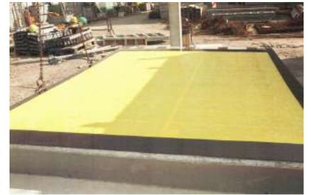
**4.- Retirada de la lámina Fullconcrete.** Se realiza de forma sencilla, basta con tirar de ella desde cualquier extremo. En caso de quedar restos de cola se puede utilizar disolvente o similar para la limpieza del panel de encofrar.
