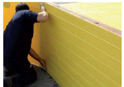
**3.2.- Fijación mediante clavos o grapas.** Se suele utilizar habitualmente cuando el panel de encofrar es de madera y no hay problema en perforarlo con los clavos o grapas. Se aconseja la aplicación de un clavo o grapa cada 10 cm aproximadamente a lo largo del perímetro de las láminas Fullconcrete.
